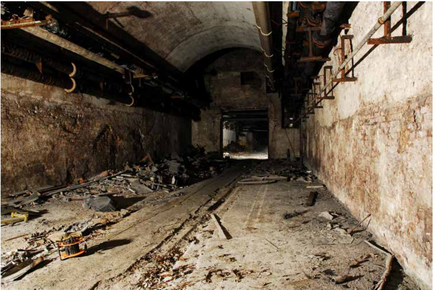
Abb.1. Altbestand des Kellerbergs, im Sommer 2012 abgerissen. © Fotoarchiv der KZ-Gedenkstätte Mauthausen/Stephan Matyus.
