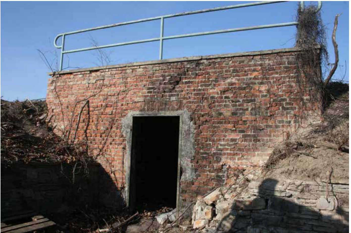
Abb. 5. Ehemaliger oberirdischer Zugang zum Luftschutzkeller. © iFAG, Thomas Pototschnig.
