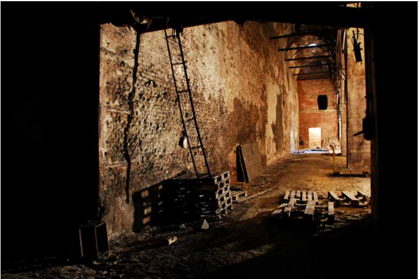
Abb. 2. Alter Lagerkeller mit Abmauerung des Luftschutzkellers. © Fotoarchiv der KZ-Gedenkstätte Mauthausen/Stephan Matyus.
