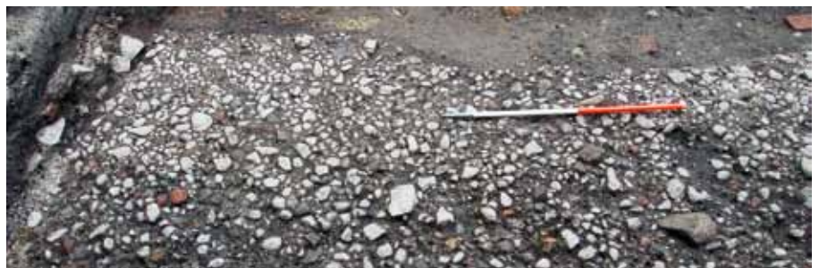
Abb. 6. Tulln Hauptplatz 2007/8, Straßenoberfläche hergestellt aus Ziegelbruch und Donaukieseln (Foto: BDA, Ute Scholz).
